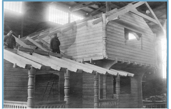
Laftehus under montering i tømmermannshallen. Foto: Akershusbasen
